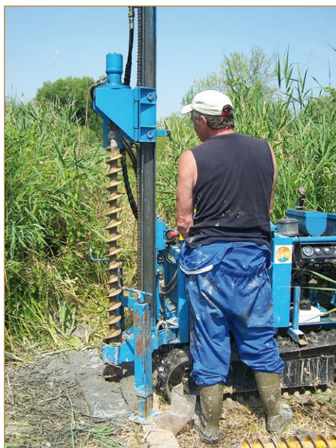
Fig. 16. Aizier, 2009. Forage réalisé au droit des infrastructures portuaires (cliché S. Sechi).
