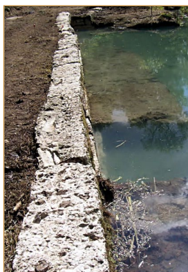
Fig. 12. Aizier, 2005, zone 1. Digue post-antique (MR1005) retenant des remblais de type « tout venant » (cliché J. M.).
