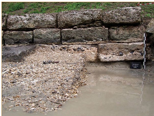
Fig. 5. Aizier, 2005 ; zone 1 : digue en calcaire à silex dégagée dans les années 1970 à l'extrémité ouest de la propriété de M. Laurent (cliché J. M.). Affleurant sous le terrain actuel, cet ouvrage colossal a été reconnu sur plusieurs dizaines de mètres. Bien que plus récent, le mode de construction de son parement est similaire à celui du quai antique.
